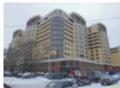
Фото 1. Жилой дом по ул. Волочаевская, 11/1
